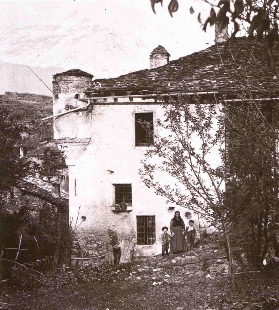
Mollare, casaforte di origine tardomedievale con bertesca angolare e feritoia nel corpo murario sottostante (da A. Gilibert, L. Michelozzi, Valsusa com'era , Susa 1976, p. 51, fig. 54).
